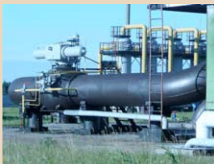
Рис.3. Добрянское ЛПУ Наружная обвязка ГПА – покрытие ЦИНОТАН+ФЕРРОТАН
